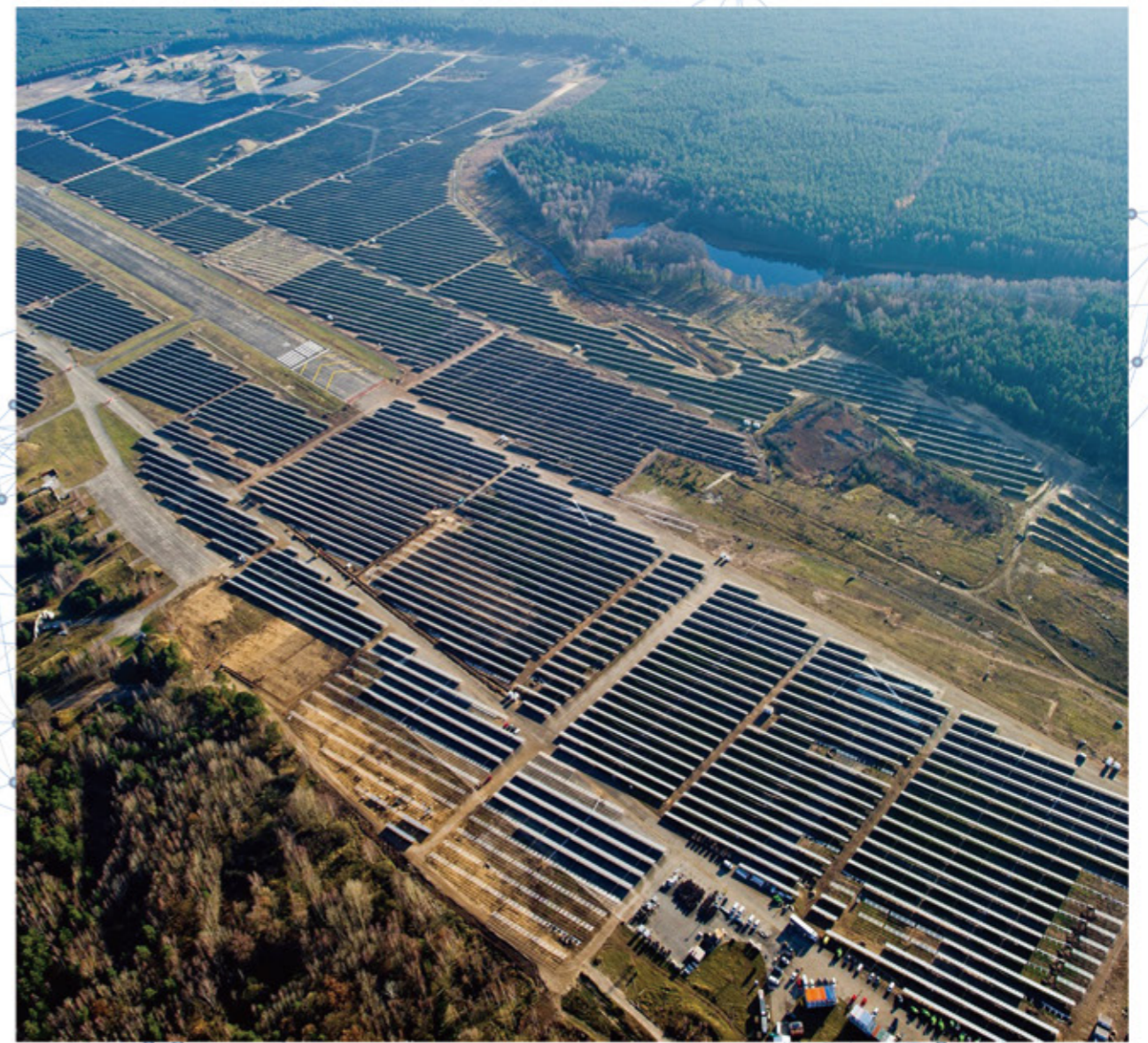
Potosi Solar PV Plant, Mexico 300MW 墨西哥波多西300MW光伏电站项目
